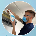
JACK WELLS, INGÉNIEUR EN RÉFRIGÉRATION nettoie l'unité murale avec le nettoyant Frionett® Evaporator Cleaner
