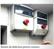
Sistem de detectare pentru camera frigorifică cu temperatură medie
